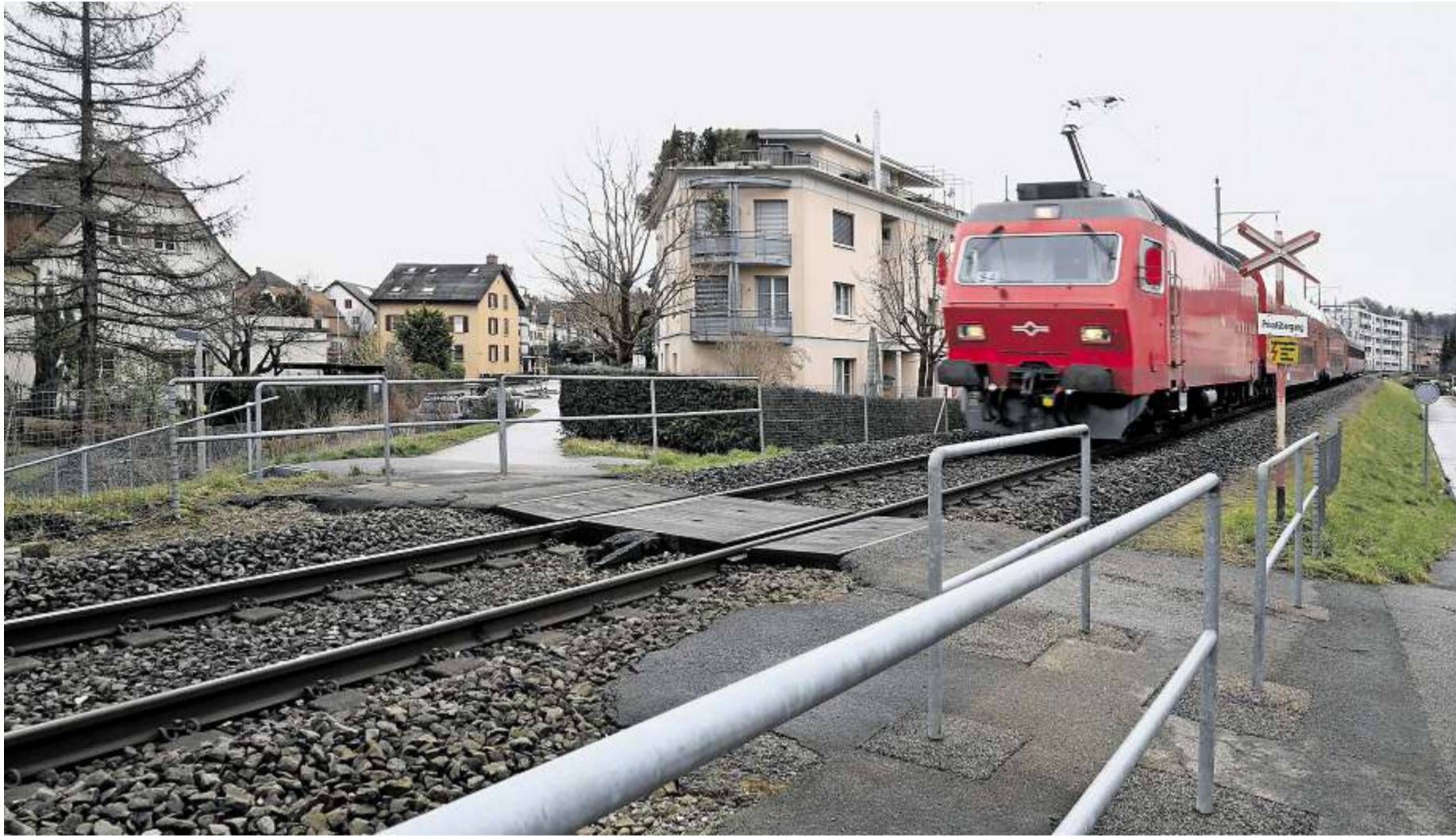
Der Bahnübergang beim Sandackerweg in Adliswil hätte durch eine Unterführung ersetzt werden sollen. Das Parlament hat dem Projekt nun eine Abfuhr erteilt.
